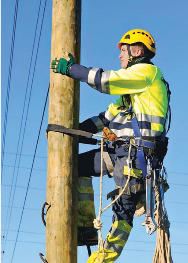
Bild 5 Freileitungsmonteur bei der Arbeit
