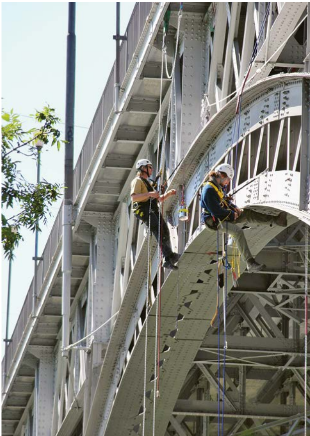
Bild 2 Arbeiten am hängenden Seil
